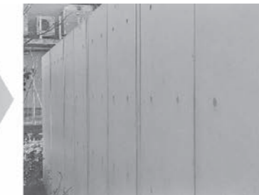
カーボンネガティブコンクリート (イメージ)
